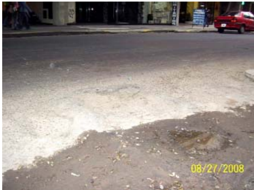
FOTO I Viejo Hundimiento de Pavimento al lado de un reciente Fresado parcial y Recapado. Calle Mario Bravo e/ de la Carcova y Gorriti
