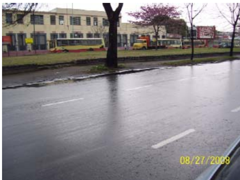
Foto VI: Margen izquierdo de Calle Amancio Alcorta, rehabilitada, sin cuneta.
