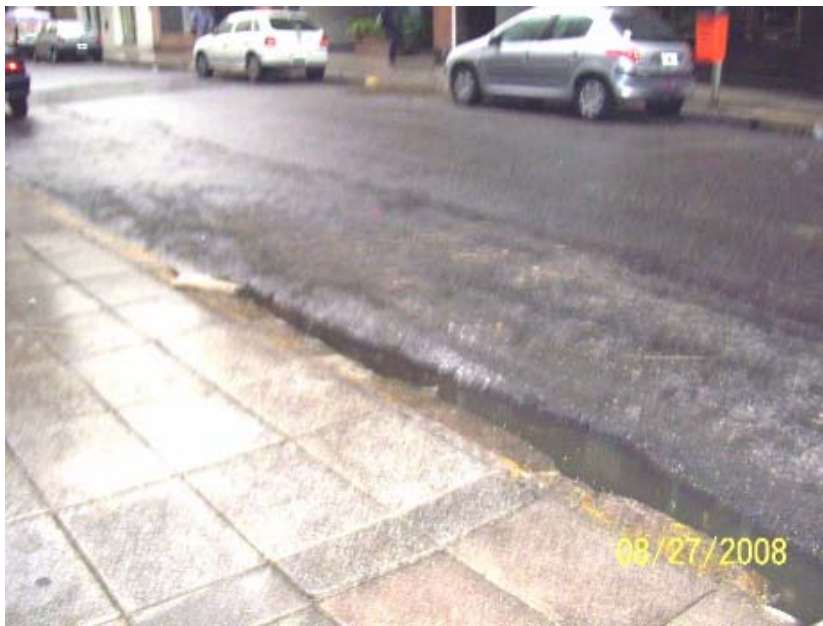
Foto VII: Recapado Parcial en faja central, sin construcción de cunetas de hormigón.
