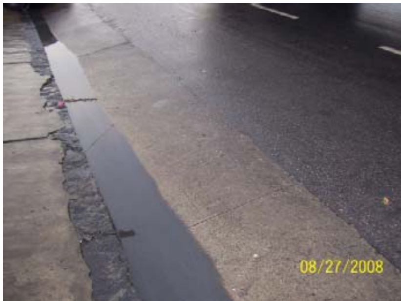
Foto V: Cuneta nueva en Rehabilitación. Calle Amancio Alcorta, margen derecho.
